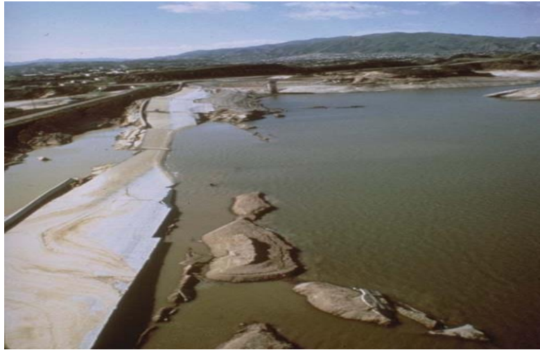
Figure 1.5 : Vue du barrage de San Fernando après son effondrement partiel lors du tremblement de terre de Sylmar en 1971 2 .
